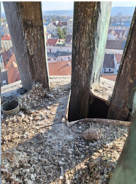
Obrázek 12 Detail kontaminace vnitřní části horního sanktusníku trusem ptactva a absence oplechování na vnitřní straně dřevěných sloupků.
