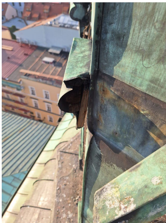
Obrázek 6 Detail uvolněného profilovaného oplechování římsy sanktusníku.
