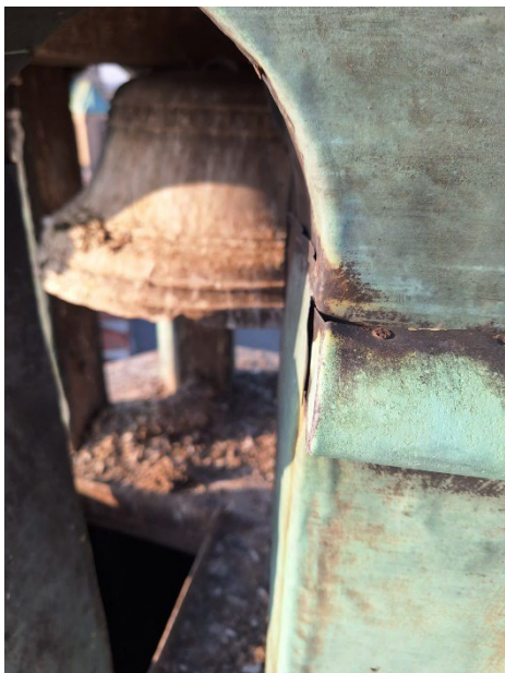
Obrázek 9 Detail železných spojovacích prvků (hřebů) měděného oplechování.
