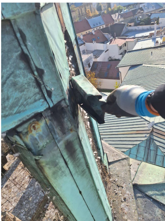
Obrázek 7 Detail uvolněného a chybějícího profilovaného oplechování římsy sanktusníku.
