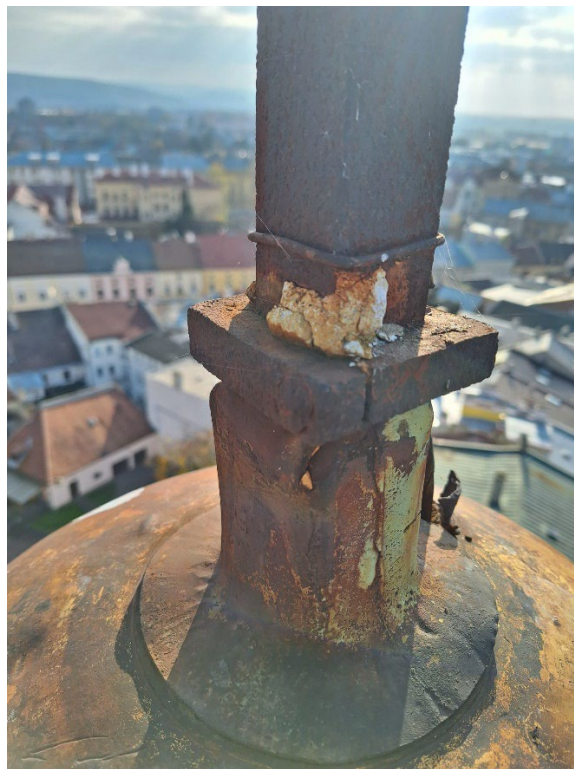
Obrázek 18 Detail ukotvení kovaného trnu v horní části měděné makovice.
