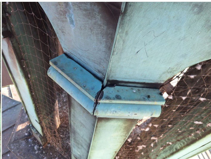
Obrázek 10 Detail prasklého cínovaného spoje měděného oplechování.
