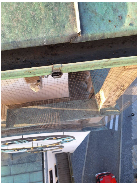
Obrázek 5 Detail poškození krytky žlabového háku.
