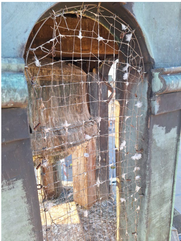
Obrázek 11 Detail nefunkční ochranné sítě proti vniknutí ptactva.
